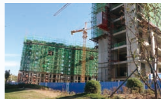
阜東新區易地扶貧搬遷及 搬遷整合工程項目
