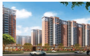
鴻泰苑 F區安居房工程
